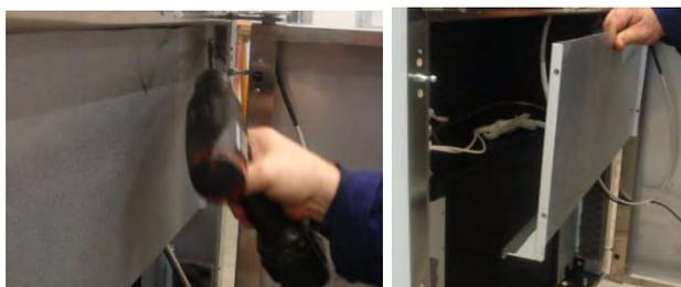
Удалить фиксирующие винты электрического щита.
