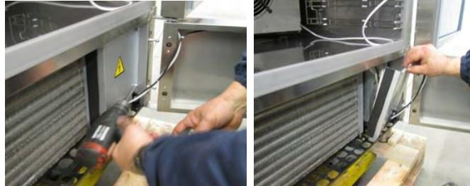
Удалить фиксирующие винты электрического щита.
