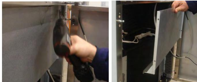
Удалить фиксирующие винты электрического щита.
